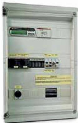
Предназначена для автоматического управления работой вентиляционного агрегата: регулирования тепловой мощности калорифера, защиты от перегрева и других критических условий работы.
