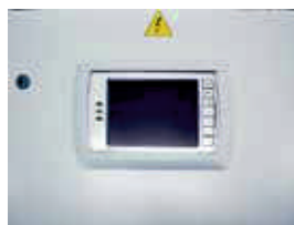
цветной графический дисплей с сенсорным экраном в составе щита
