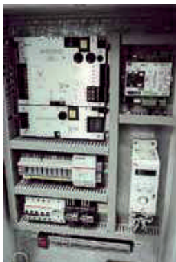
щит управления насосной станцией
